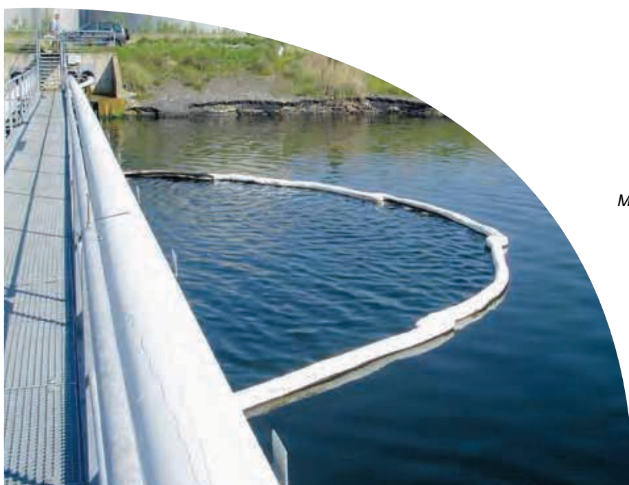
Vairāku savienotu bonu barjera, lai apņemt un kontrolētu avāriju.
