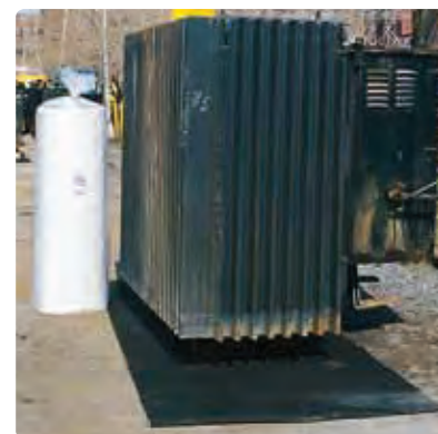
Ideāls zem tekošiem transformatoriem
