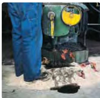
Problēma: Noplūdes un pilējumi rada slidenu grīdu.
