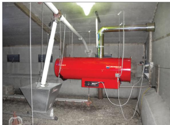
**PHOEN/S - SUSPENDED INDIRECT COMBUSTION SPACE HEATERS
